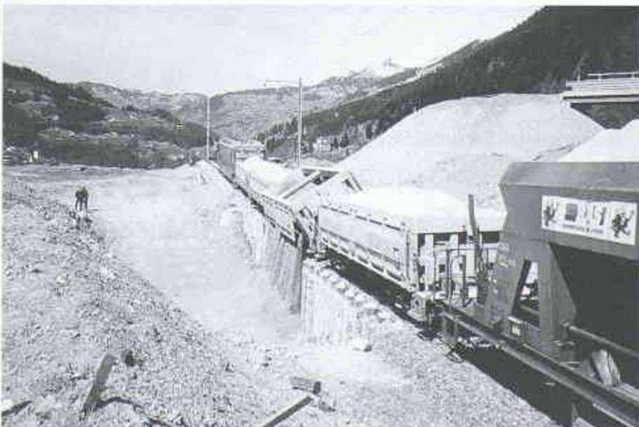
Kippwand Büel / 2 Fau- und 1 Fad-Wagen beim Entleeren (Foto: Bauleitung Nord)
