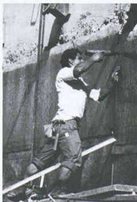
Problemlöse Verlegung von Enkadrain CK auch auf unregelmässigem Untergrund
