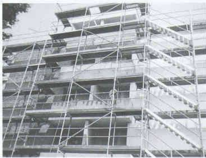
2 Gebäudesanierung: Isolation, neue Fenster, Balkone und Haustechnik (Bild: T. Glatthard)
