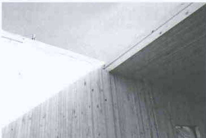
3 Einsatz von Brettstapel- elementen sowohl für HBV-Decke als auch für Wandelement
