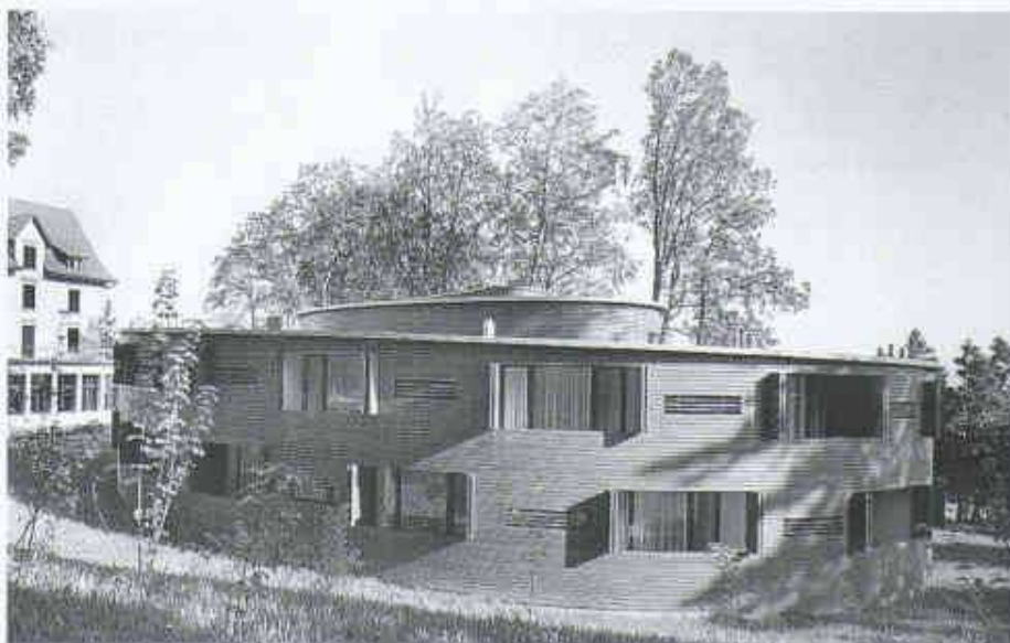
2 Schraubenförmiger Pavillon – Neubau des Hotels Zürichberg, Zürich 1995. Die Architekten Burkhalter und Sumi zeigen die innere Funktion des Bauwerkes von aussen auf (Foto: H. Helfenstein, Zürich)
