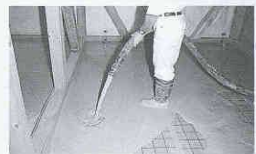
Vom konventionellen Zementüberzug ... ... zum wirtschaftlichen Fließunterlagsboden
