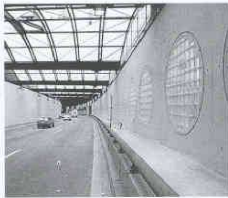
Verwendung unterschiedlicher Materialien und Ausführungen der Verglasungen einer Auto-bahnüberdeckung unter – neben anderem – Einbezug der Splitterwirkungen bei einer Explosion
