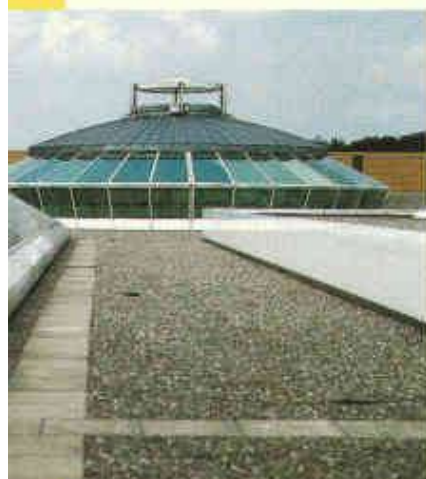
Umbau Einkaufszentrum Glatt. Mit Sarnafil T.
