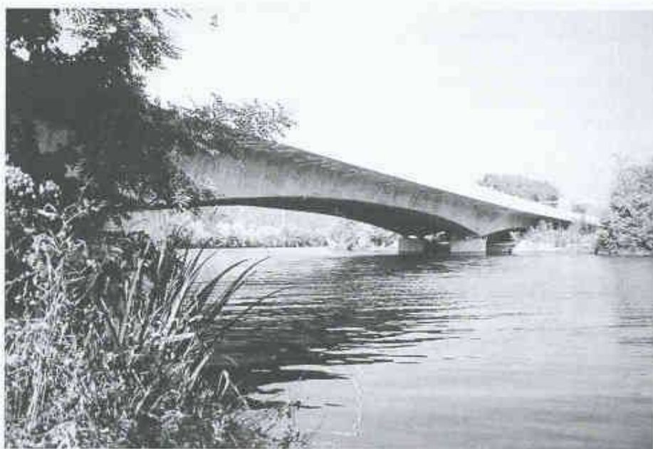
Die Aarebrücke quert, nur wenig über dem Gelände, mit schön geschwungenem Vouten-
