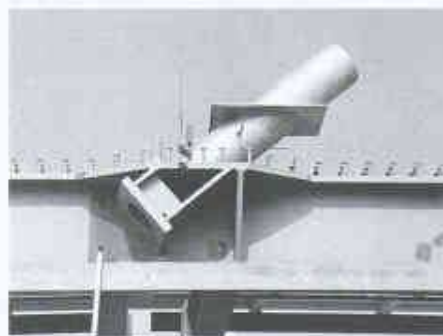
4 Spannkabel: Verankerungsdetail
