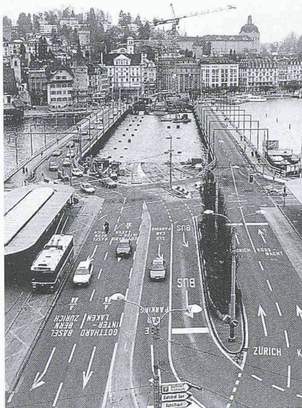
Der Brückenneubau entsteht zwischen den beiden Hilfsbrücken, die den Verkehr während der Bauzeit aufnehmen. In diesem «Loch» erkennt man die Bohrpfähle für die Fundation (Bild: Comet)
