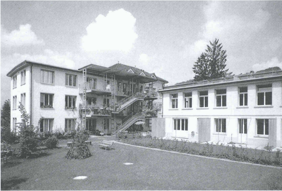
Alte Weberei, Ebnet-Kappel: Konsequente Anwendung der Kriterien der Nachhaltigkeit und behutsamer Umgang mit der vorhandenen Bausubstanz bei der Umnutzung zu Wohnzwecken
