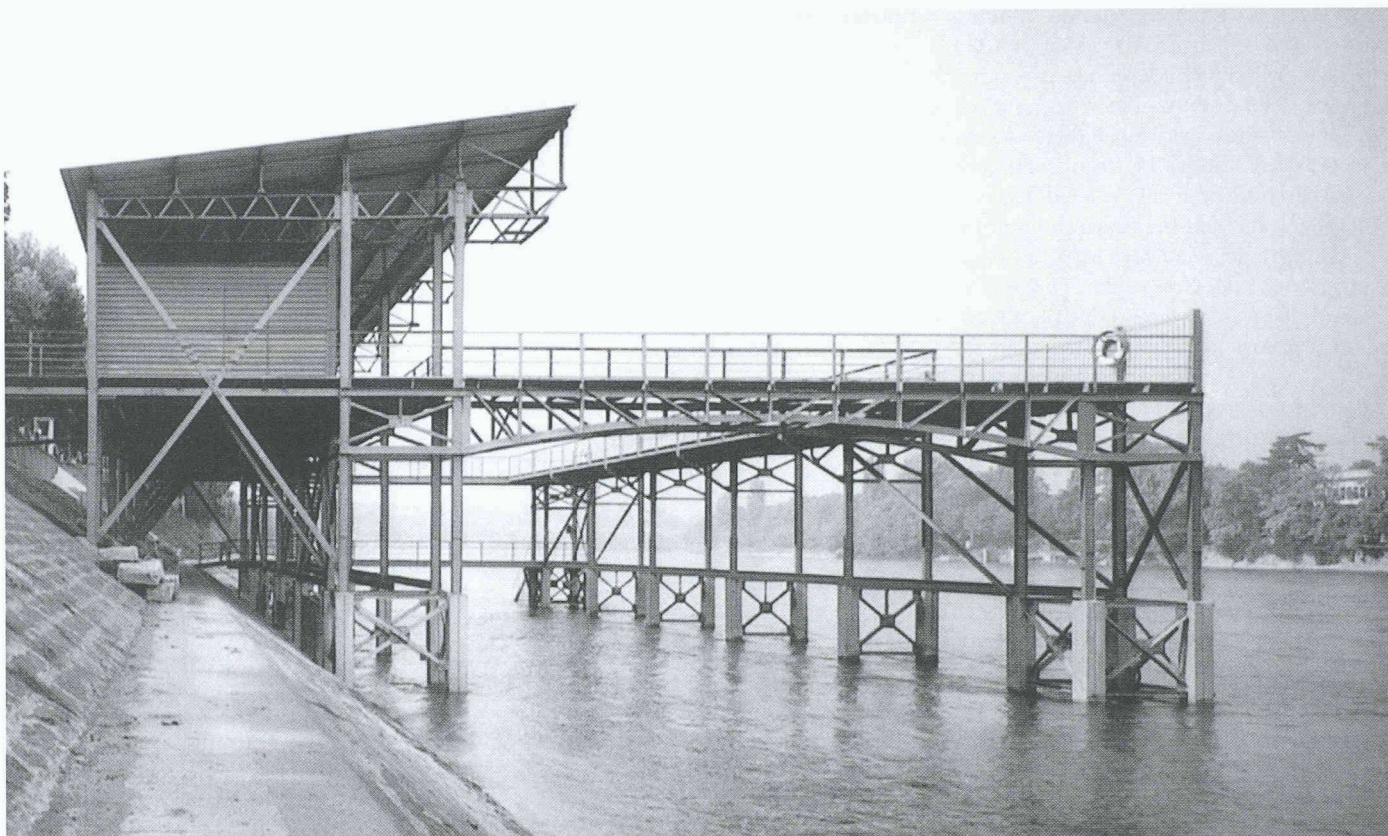
Rheinbad Breite, Basel: Das abbruchgefährdete Bad konnte durch eine Verkleinerung, die die Betriebskosten reduziert, erhalten werden, wie
