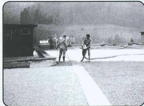
Absaugen von Kies, Sand und Humus ab Flachdach, bei Baustellen und Kellern mit erschwerem Zugang.
