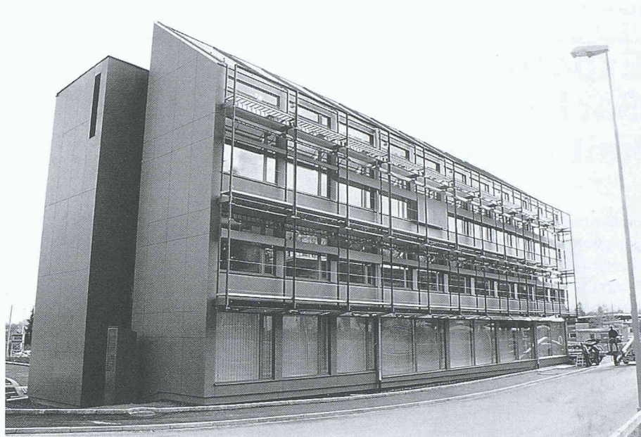
Ausgeführte Fassade mit Sonnenschutzsystem
