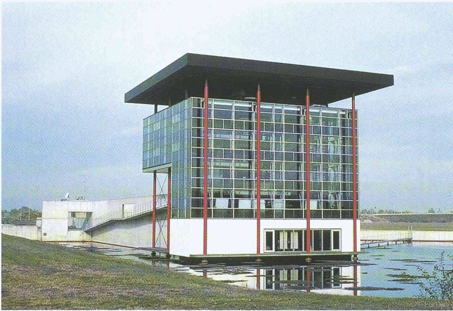
Sonnenschutz mit Spiegellamellen, die in Isoliergläser eingebaut werden: Geschäftshaus Haans, Jo Coenen, Tilburg, Niederlande, 1992
