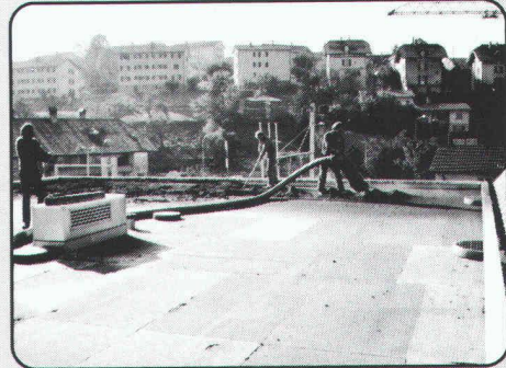
Begrünen von Flachdächern, Dachgärten und Böschungen.
