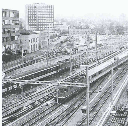
6 Inselbaustelle (Gleisbau) zwischen provisorischen Streckengleisen
