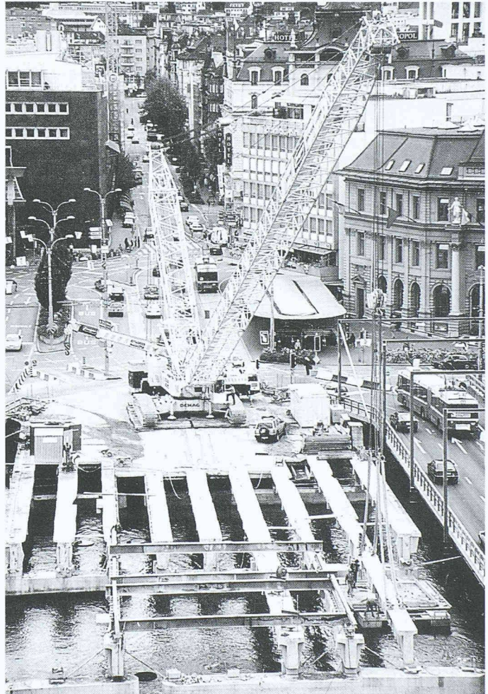
1 Abbrucharbeiten der alten Brücke. Der Raupenkran hebt die Längsträger heraus
