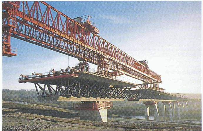
Boulonnais-Viadukt: Segment mit Raum- fachwerk
