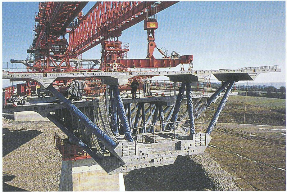
Boulonnais-Viadukt: Segment mit Raum- fachwerk
