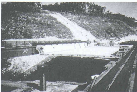
7 Channel Bridge: Einschieben eines Segments auf den Montage-Stahlträgern
