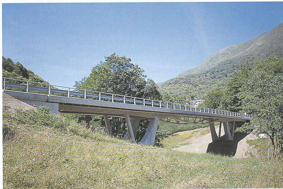
8 Brücke über den Capriasca in Odogno TI
