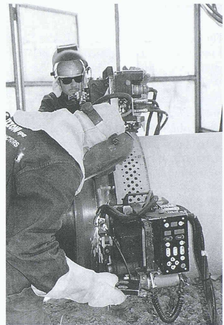
Der grösste Teil der rund 4000 Nähte wird – als Novum im Schweizer Leitungsbau – mit Automaten im Schutzgasverfahren geschweisst und mit computerüberwachtem Ultraschall geprüft
