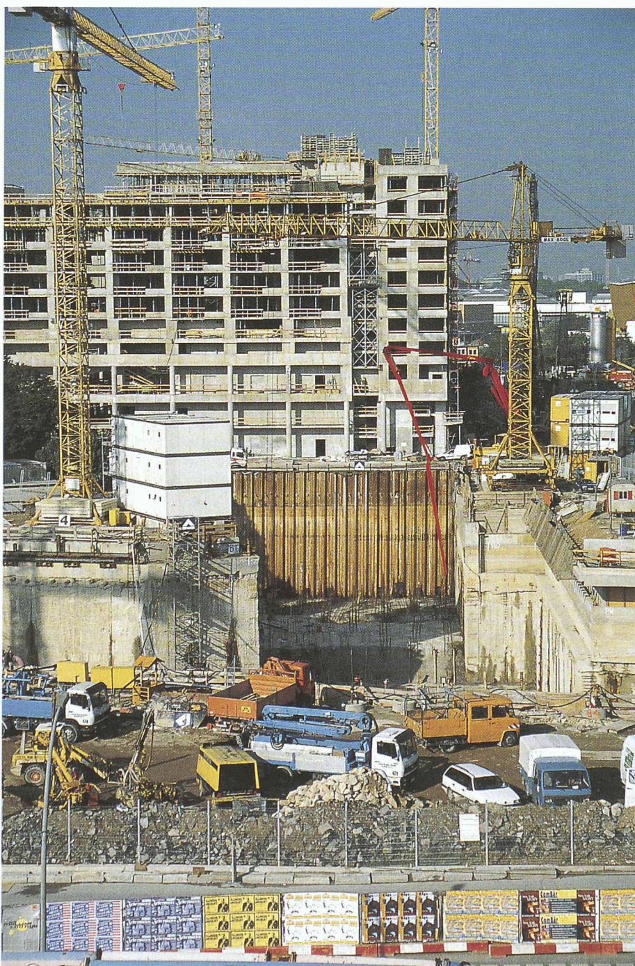
Grossbaustelle Potsdamer Platz, Berlin (Bild: H. Gadiant)
