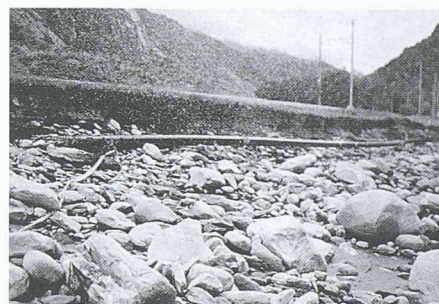
Durch das Unwetter im August 1987 freigespülte Teile der Erdgasleitung Rhonetal im Goms
