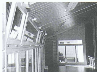
Ostfassade, geöffnete Stellung eines Oberlichts: Kippfenster, WindowMaster-Fensteröffner mit Stromüberführung in der Kette Typ WMI 100
