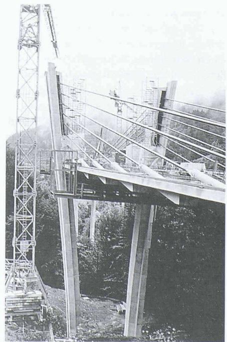
Die 540 m lange Sunnibergbrücke der Umfahrung Klosters im Bau: Gut sichtbar die auseinanderstrebenden Pylonpfeiler und die dünne Fahrbahnplatte (Bild: Comet)
