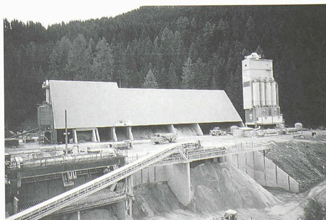
1 Rotationskippe Vereinatunnel Nord
