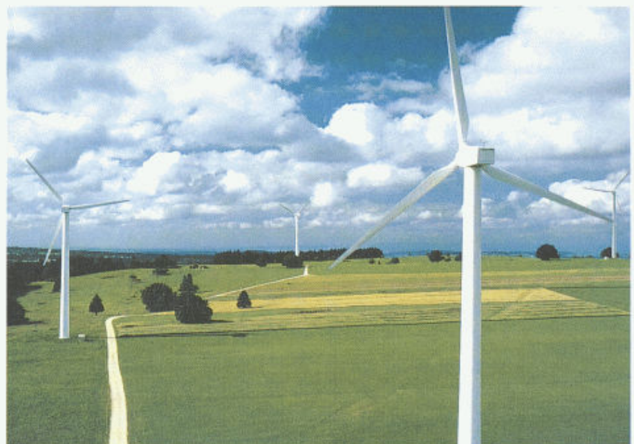
Das Windkraftwerk Mont Crosin wurde kürzlich um eine vierte Grossturbine erweitert (Fotomontage). Die Jahresproduktion erhöht sich damit auf 2,5 Millionen Kilowattstunden (Bild: Juvent SA)
