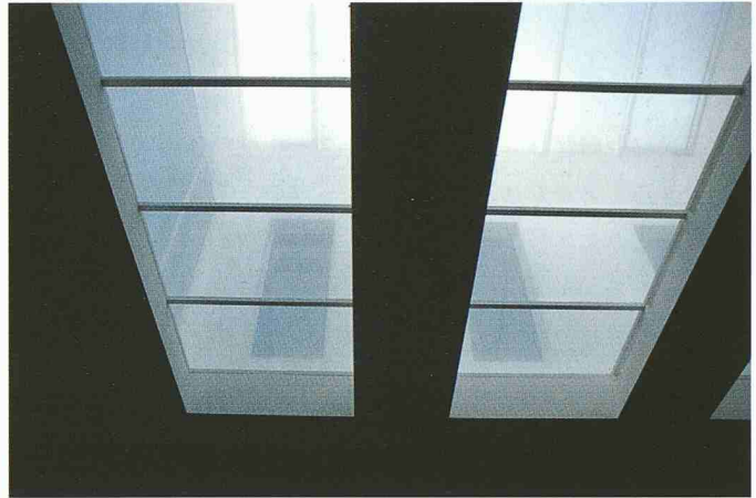
Blick in die Lichtkammer im 3. Obergeschoss (Bild: Martin Tschanz)
