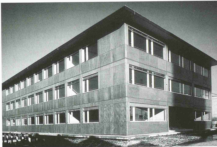
Beim neuen Forschungsgebäude der Firma Schindler kam eine modulare Holzbauweise zum Einsatz. Gleichzeitig dient es zur Präsentation eines neuartigen Aufzugssystems (Bild: Hans Ege)
