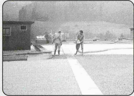
Absaugen von Kies, Sand und Humus ab Flach- dach, bei Baustellen und Kellern mit erschwer- tem Zugang.
