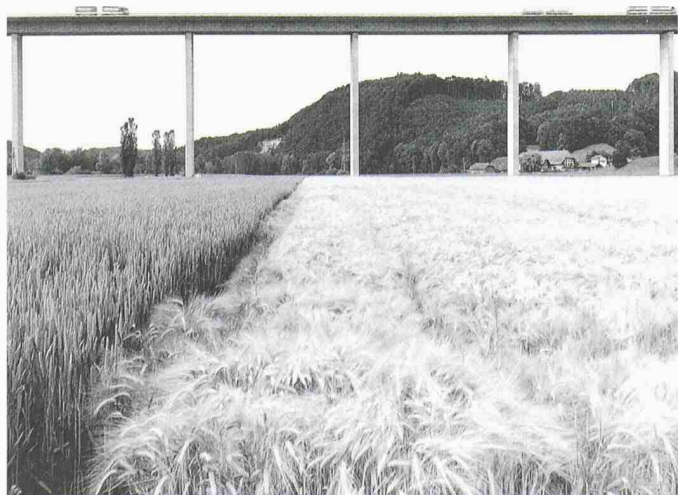
A1-Viadukt Gümmenen BE (Bild aus dem Band «Autoland», Nicolas Faure)
