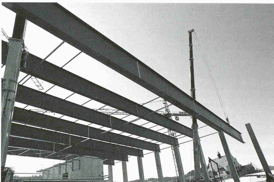
Die neue Olma-Halle 9 in St. Gallen ist derzeit im Bau. Bemerkenswert ist die Konstruktion des 114 Meter langen Stahldaches
