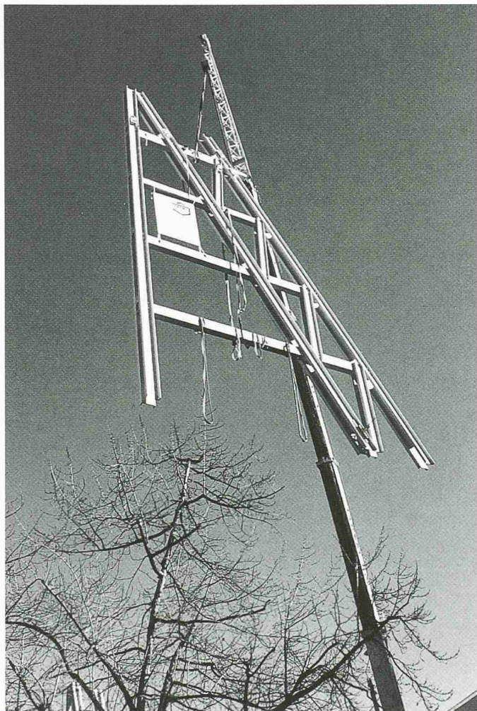
10 Versetzen des dritten Rahmens mit dem Pneukran
