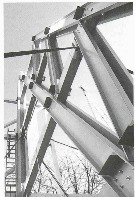
Zangenbauweise der GFK-Struktur
