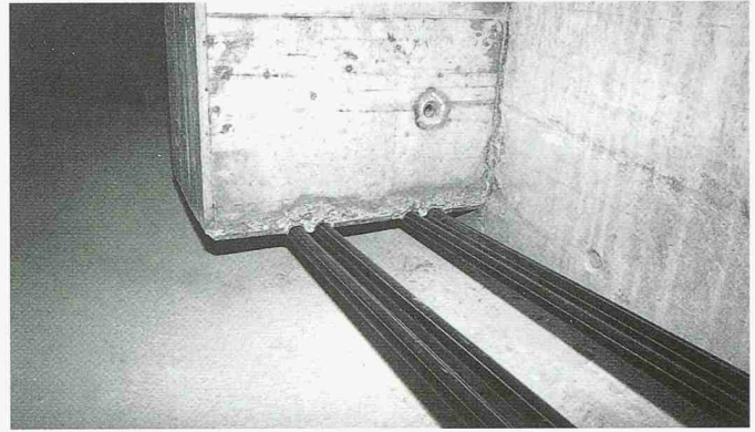
7 Nachträglich einbetonierte Kabel-Umlenkstelle im Feld
