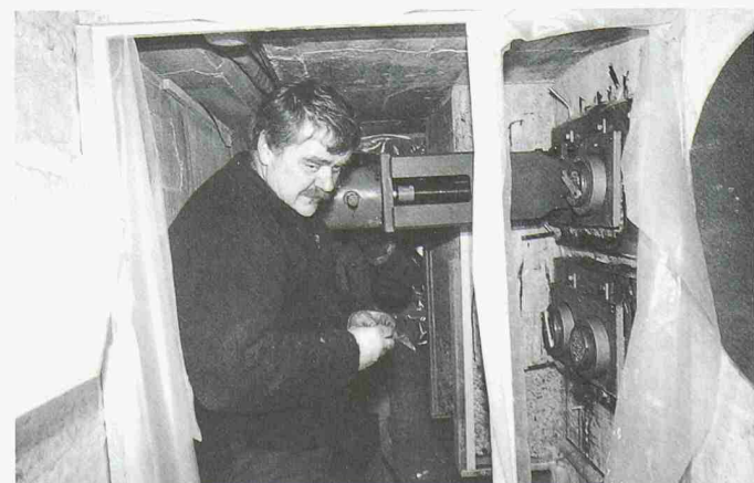
10 Spannen der Karbonkabel in der Widerlagerkammer Seite Camedo (Bild: Empa)
