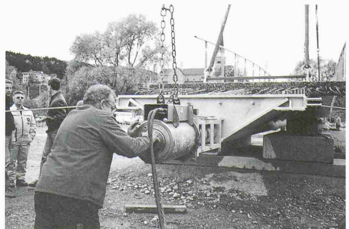
3 Spannstuhl auf Auflagerscheiben beim Vorspannen der CFK-Kabel
