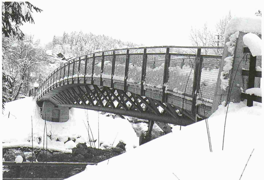
1 Ansicht der Brücke vom nördlichen Widerlager aus
