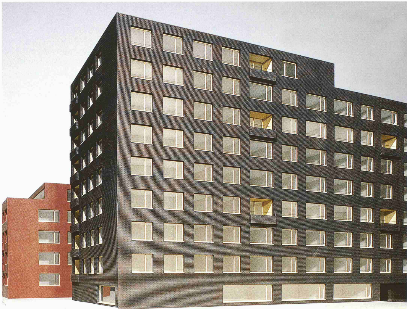
KraftWerk1-Projekt für Zürich-West, Haus A, von Stücheli Architekten, Zürich (Bild: Arazebra, Helbling & Kupferschmid)
