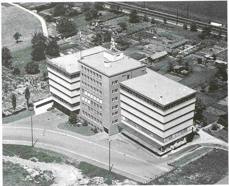
2 Luftaufnahme kurz nach der Fertigstellung, im Hintergrund die Schrebergärten und die SBB-Doppelspur; das Anschlussgeleise für den Warenverlad fehlt noch
