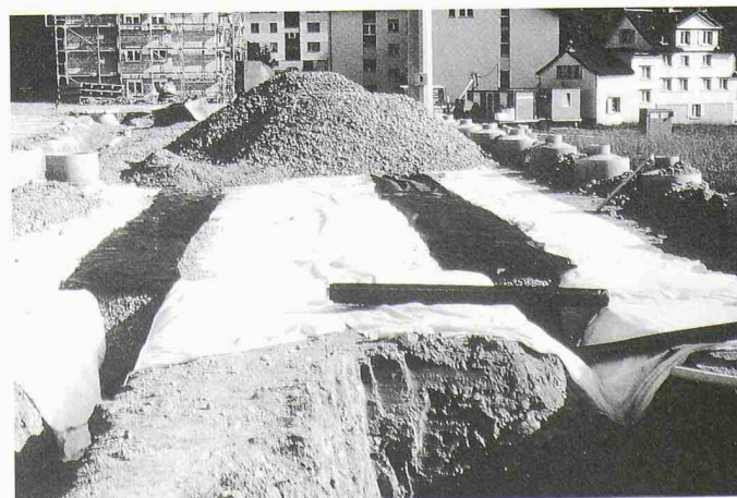
1 Geotextilien im Sportplatzbau mit Trenn- und Filteraufgaben: Untergrund/Sickermaterial: Vlies (weiss), Rasentragschicht/Sickermaterial: = Gewebe (schwarz), Bild: Autor
