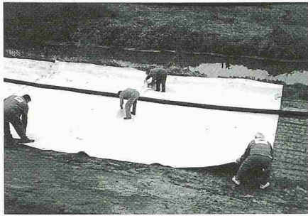
2 Sicherung des Überstömbereichs gegen Erosion mit Filtermatten
