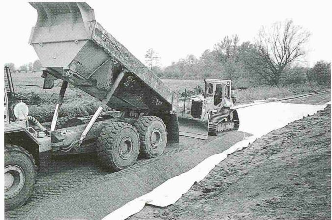
3 Mechanische Widerstandsfähigkeit beim Einbau des Deckwerks ist ein entscheidendes Qualitätskriterium
