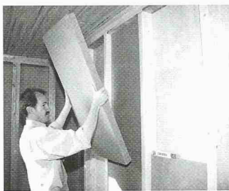
Der Holzfaserdämmstoff Pavatherm sorgt auch beim Wandaufbau für einen wirkungsvollen Schutz vor Kälte, Hitze und Schall
