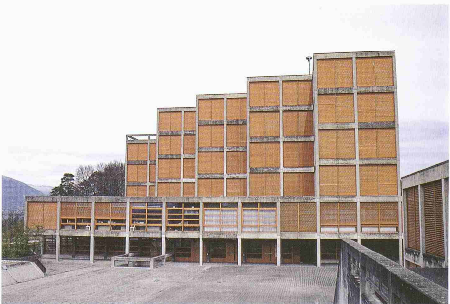
1 Ingenieurschule (EINEV) Yverdon-les-Bains: Fassade, Westseite (Bild: E. de Lainsecq, Yverne)
