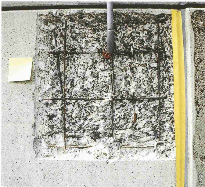
Messstelle Typ «reprofilierte Bereiche» vor der Reprofilierung
