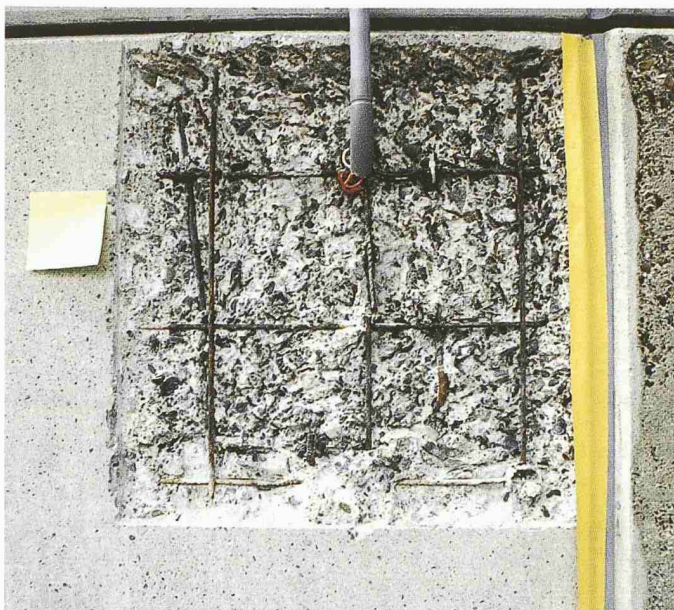
Messstelle Typ «reprofilierte Bereiche» vor der Reprofilierung
