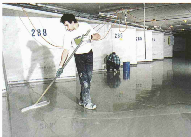
Applikation des Parkbelagsystems (Bild: F. Podolak, Wollerau)
