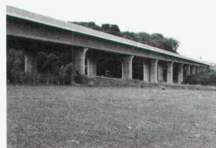
A1 Viadukt Löwenberg
