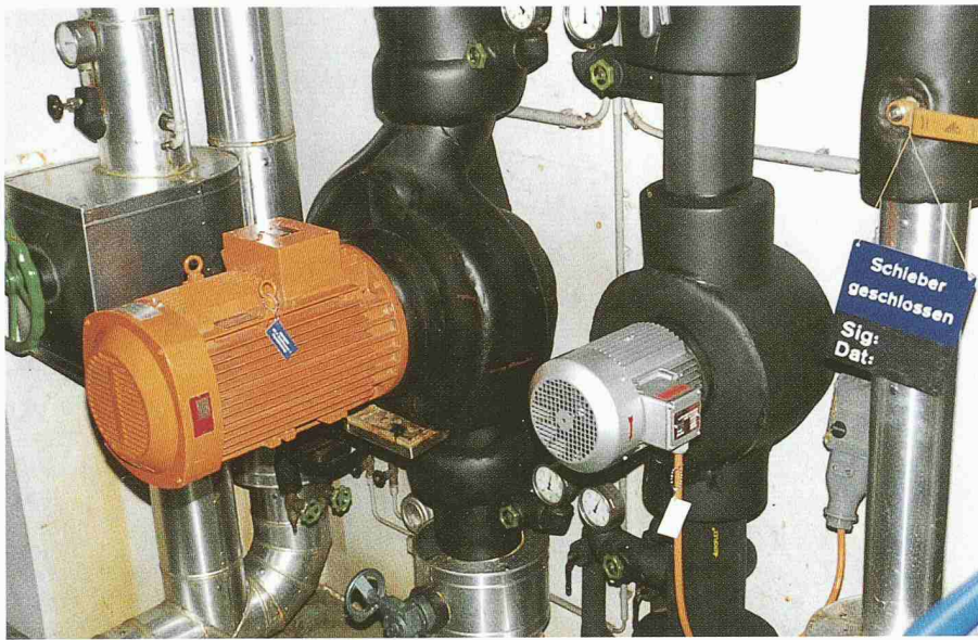
Teilprojekt Pumpenersatz: bis anhin verwendete Pumpe (links) für ein Umluftkühlnetz, angepasste dimensionierte Pumpe (rechts), Paybackzeit < 1 Jahr
