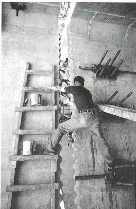
Aufbringen des Epoxidmörtels in der Segmentfuge
