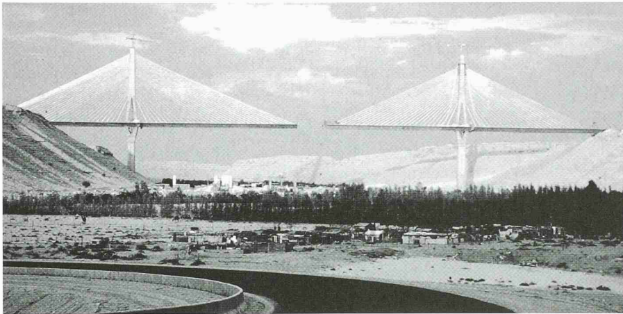
Ansicht der Brücke in der fortgeschrittenen Freivorbauphase
