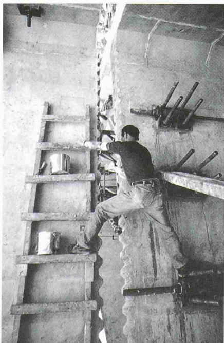
Aufbringen des Epoxidmörtels in der Segmentfuge
