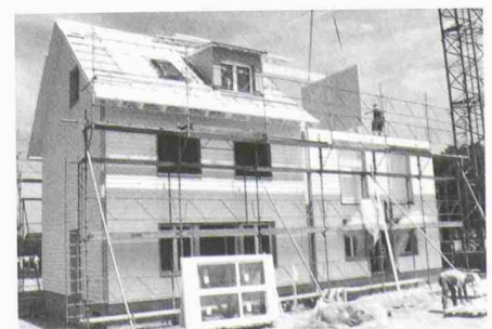
Noah-Haus nach Minergie-Standard, Pilotanlage 1 «Grafstal», Kanton Zürich (Alfredo Piatti AG). Das Bild zeigt den Bau eines Holz-Leichtbaus in Grosstafelbauweise (Häring AG, Pratteln, BL). Eine Haushälfte wird in einem Tag auf dem vorbereiteten Fundament errichtet
