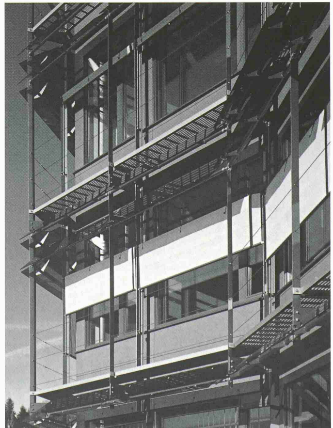
Das Bürogebäude einer Ingenieurunternehmung in Esslingen ist Teil einer zukunftsweisenden Vorortplanung und selbst Resultat einer nachhaltigen Denkweise (Architekten: Angéll/Graham/Pfenniger/Scholl, Zürich)
