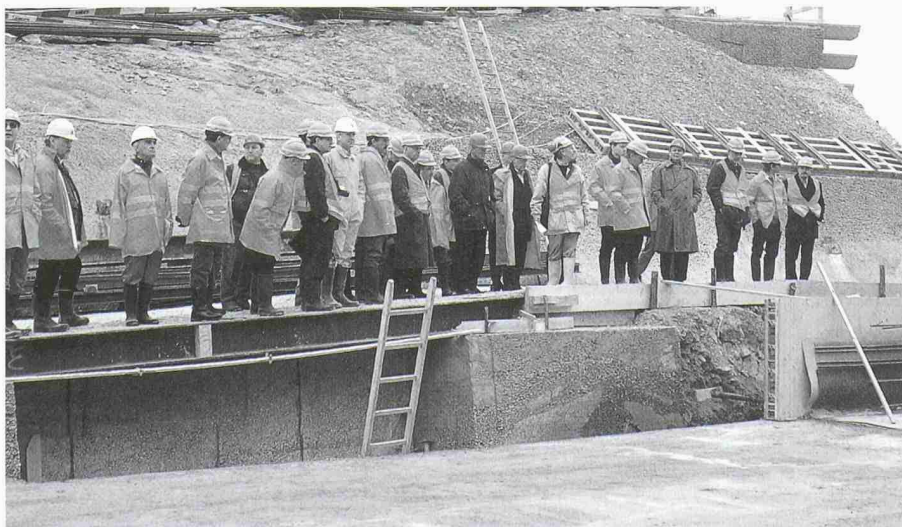
Baustelle der Bahn 2000 Zürich-Thalwil
