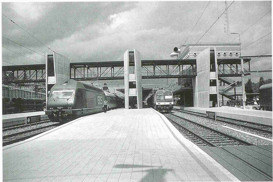
2 Perron, Passerelle und Stellwerk von Osten
