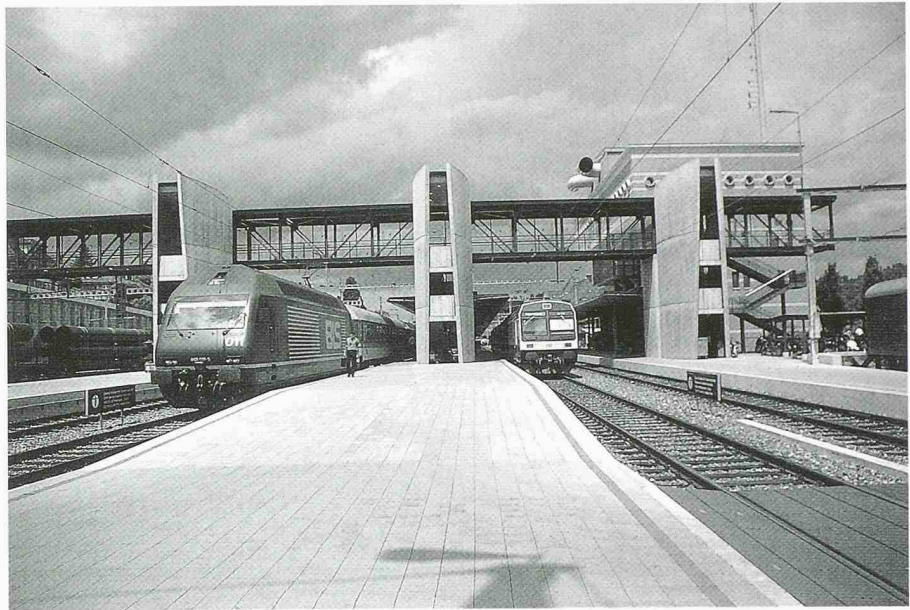
2 Perron, Passerelle und Stellwerk von Osten
